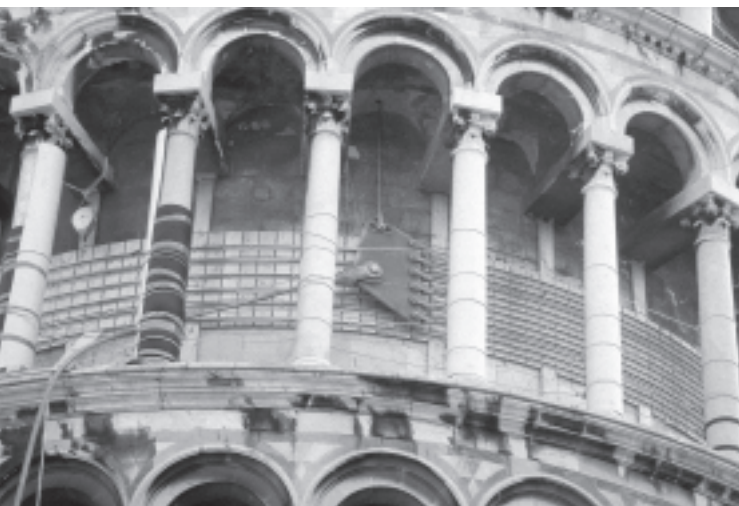
Cerclage du deuxième étage, amorce des cables
