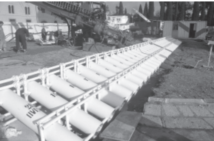
Sous-excavations, batterie des tubes guides pour l'enfoncement des vrilles
